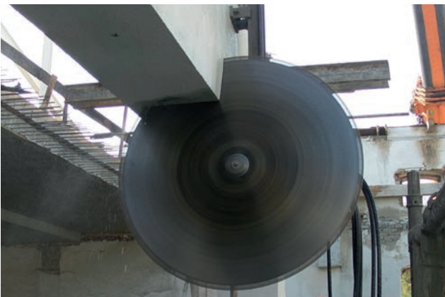
Řezání nosníku stěnovou pilou.
