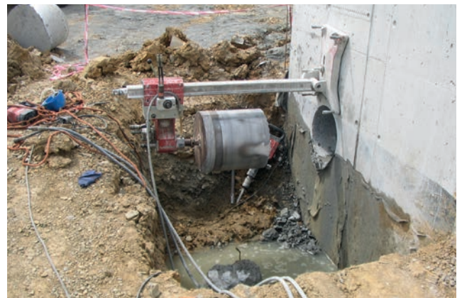
Vyvtřání průchodu v betonových šachtách.
