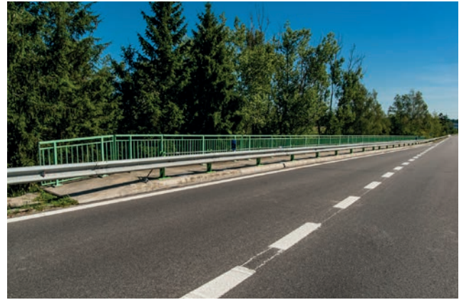
Most 24-008 přes Zlatou stoku u Třeboně se svodidlem MS4-A3/H2.
