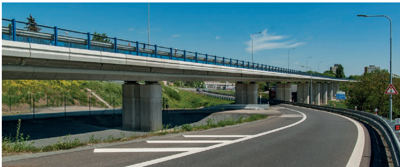
Svodidla MS4-1/H2 a ZMS4-1/H2 na estakádě I/55 v Přerově.
