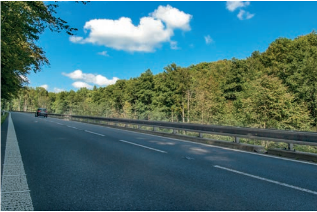
Svodidlo MS4/H2 na opěrné zdi silnice I/57 Vrchy v délce cca 2 km.
